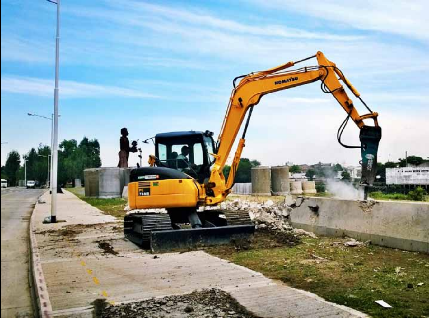
Mini excavadora PC 78 realizando trabajos de demolición. Avellaneda, provincia de Buenos Aires.
