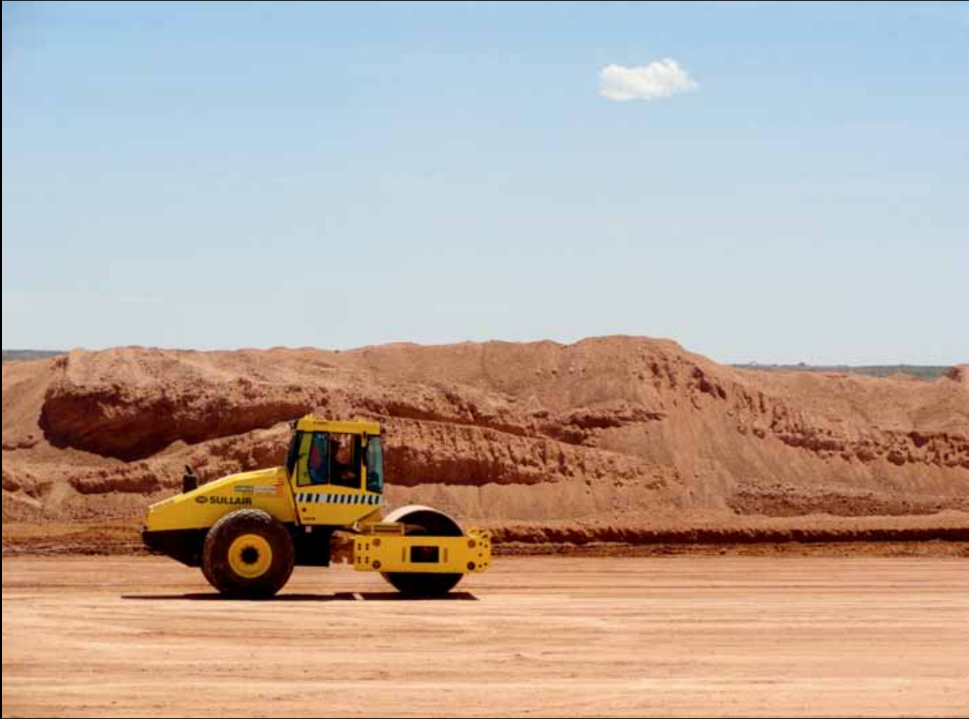
Compactador preparando piletas de contención en Loma Campana.
